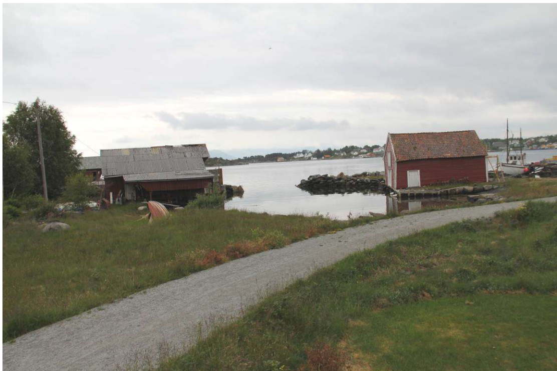
Figur 4.25 Nøstmiljø på Langøy. Bygget til høyre fra før 1937, mot øst. Foto: Ø. Engedal.
