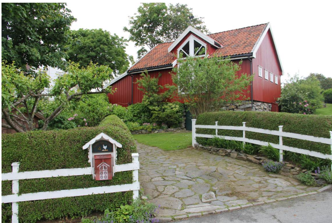
Figur 4.5 Uthus/driftsbygning på Bjørnøy gård, mot nordvest. Foto: Ø. Engedal.
